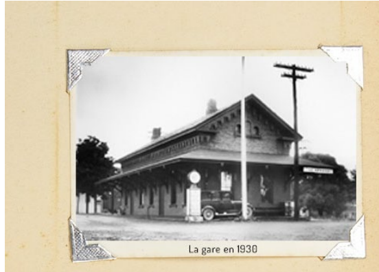
Image 7,1 Face arrière et latérale de la Centrale Vermont en 1930 26
