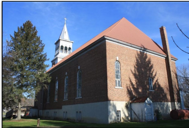
Image 1.2 : Façade arrière de l'église Notre-Dame-de-Lourdes 2
